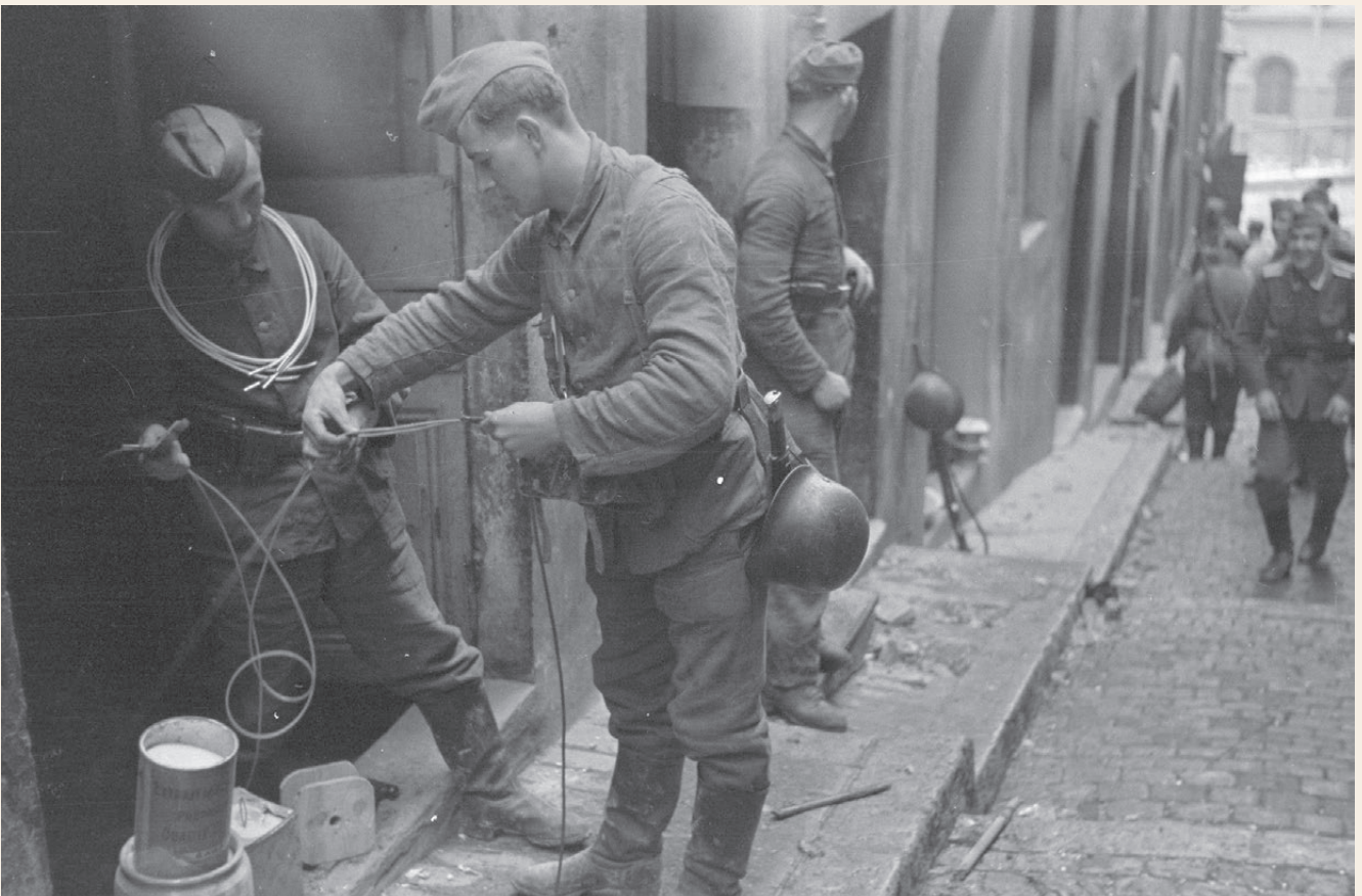
Installation des mèches des explosifs © Bild 101I-027-1480-21, Photo : Vennemann - Bundesarchiv
