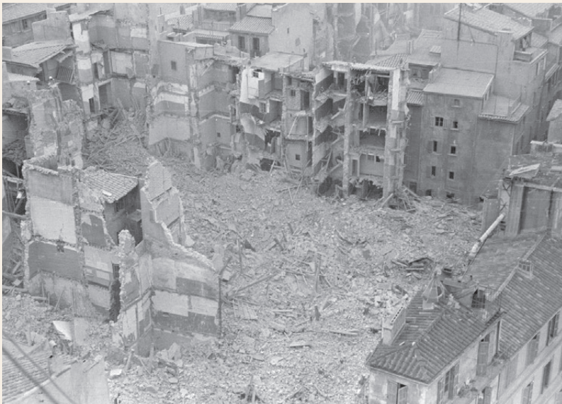
Les destructions vues depuis le pont à transbordeur © Bild 1011-027-1481-11, Photo: Vennemann - Bundesarchiv
